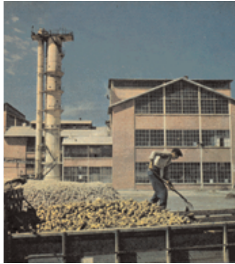
Erzincan Şeker Fabrikası
